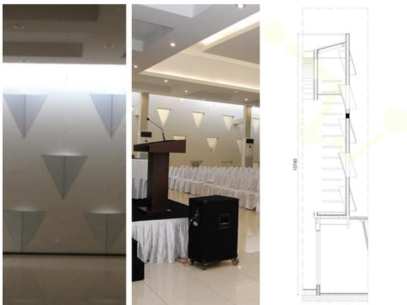
Bentuk-bentuk segitiga yang terdapat di dinding lantai dua mempunyai fungsi tambahan di eksterior yaitu lubang menyembunyikan lampu. Segitiga yang muncul keluar di dalamnya terdapat lampu hemat energi yang pada malam
