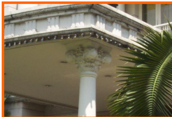
Kolom struktural yang ada di bagian teras
