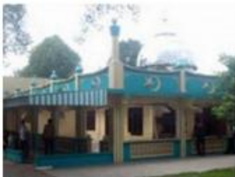
Gambar Masjid Al Ikhlas Jalan Timor, sebelum dibongkar
